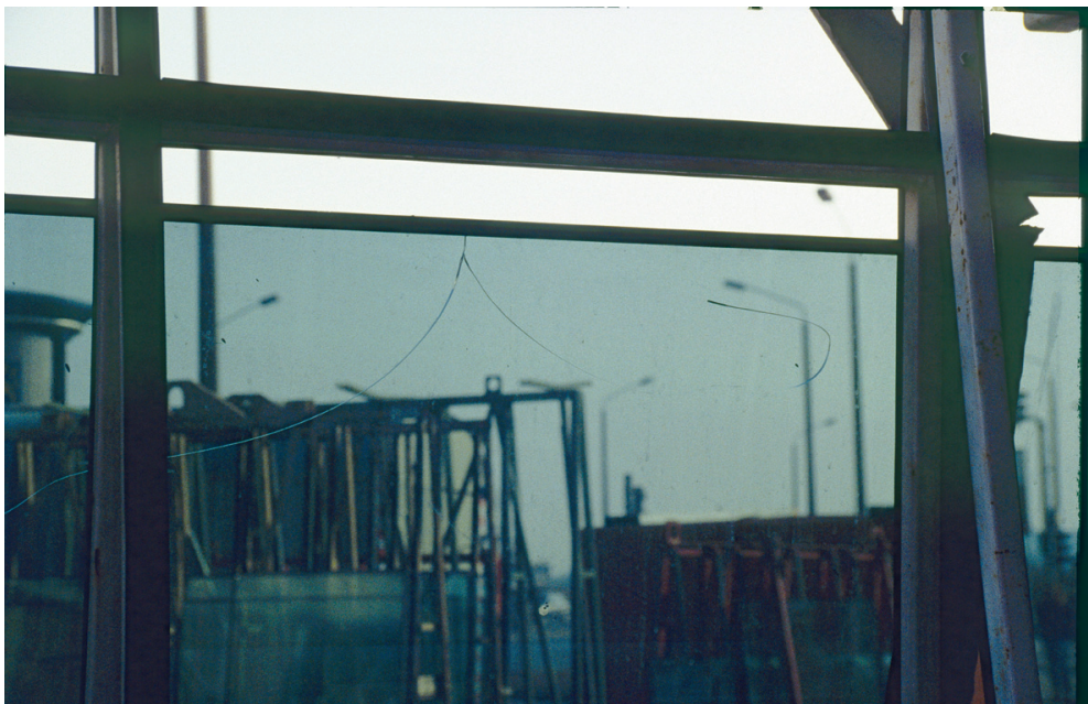
Thermischer Bruch an nicht vorgespanntem, absorbierendem Sonnenschutzglas.
